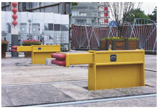
图中的终点止动器是专门为北京的老式有轨电车重建项目而设计的,带有橡胶垫衬,旨在消减中心冲击力。固定式终点止动器设有 Oleo 液压 装置(一台 Type 54 型装置,可复原行程:400mm)。冲击容量:160kJ。
