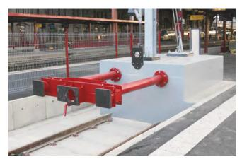
一般用于地铁和主干线,旨在消减中心冲击力和侧面冲击力。设有Oleo 液压装置的混凝土基础(两台 Oleo Type 718 型装置,可复原行程: 1800mm)。列车质量: 267 吨,冲击速度: 12km/h,冲击容量: 2016kl,安装长度: 5.5m。
